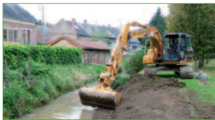
Restauration de berge (Roye)
