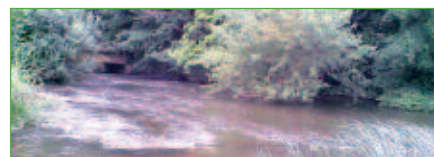
Contre-fossé à Méricourt-sur-Somme
